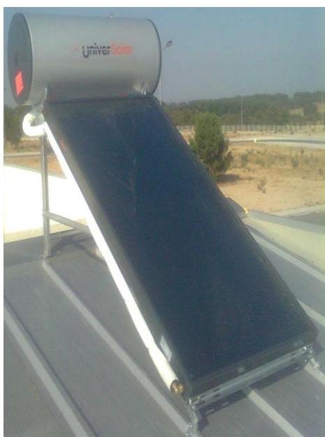
Figura 3 – sistema de termossifão (aquecimento de águas sanitárias) [6]
