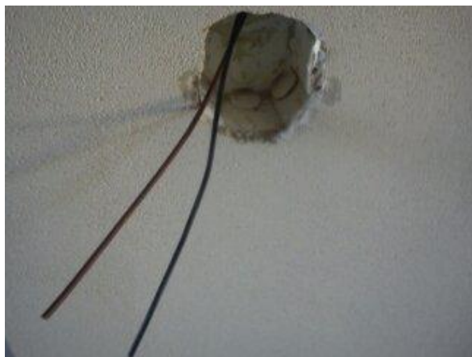
Fig.11 Caixa para interruptor com os respectivos condutores.
