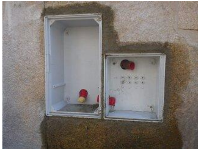
Fig.14 Caixas para contador e P100 depois de ser chumbadas e niveladas
