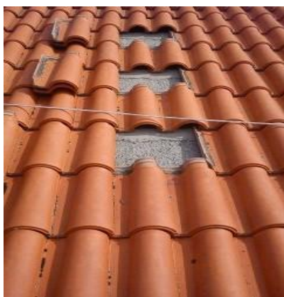
Fig.16 Telhas retiradas para colocação das bases.
