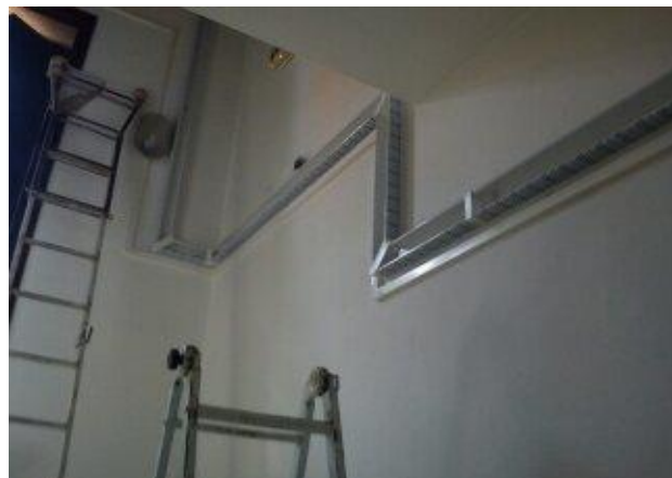
Fig.15 Calha colocada na parede.
