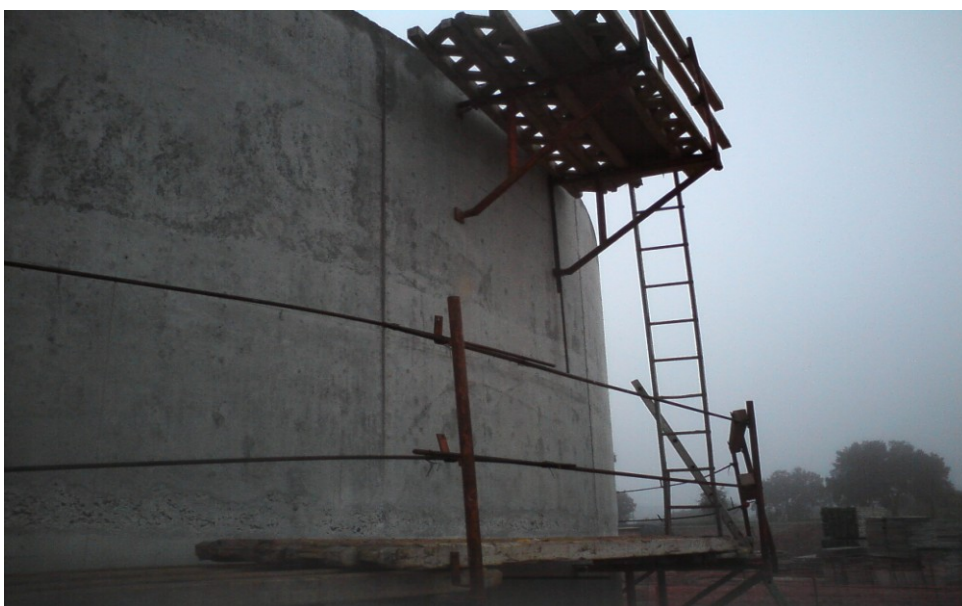
Figura 2. Reservatório de água
