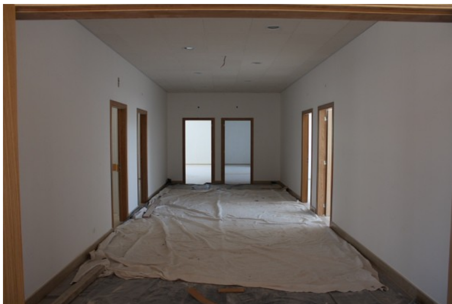
Figura 10. Interior – 1º andar, Moradia do Fundão
