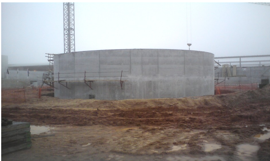
Figura 1. Reservatório de água
