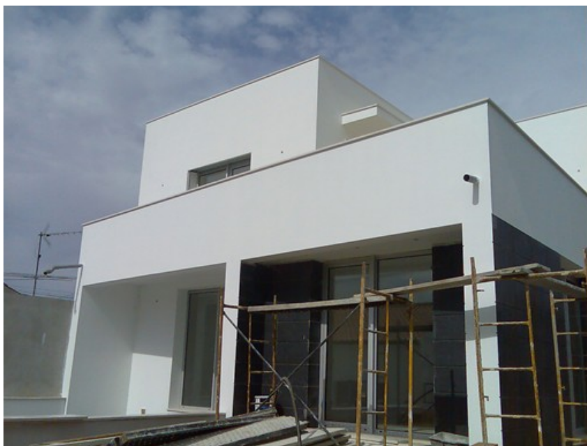
Figura 12. Exterior – Fachada Principal, Moradia do Fundão
