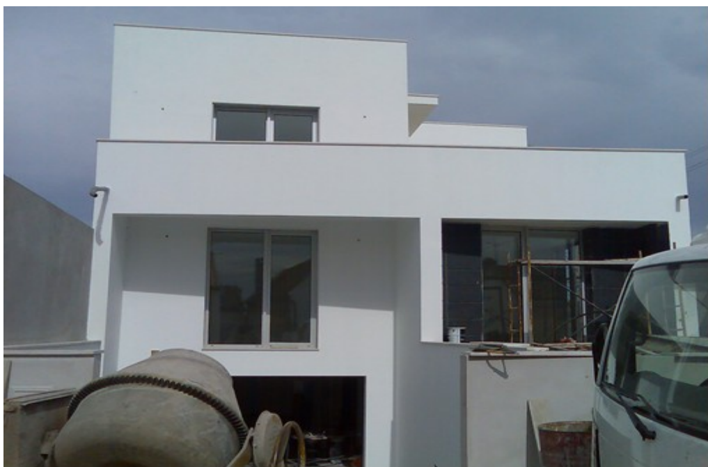
Figura 13. Exterior – Fachada Posterior, Moradia do Fundão
