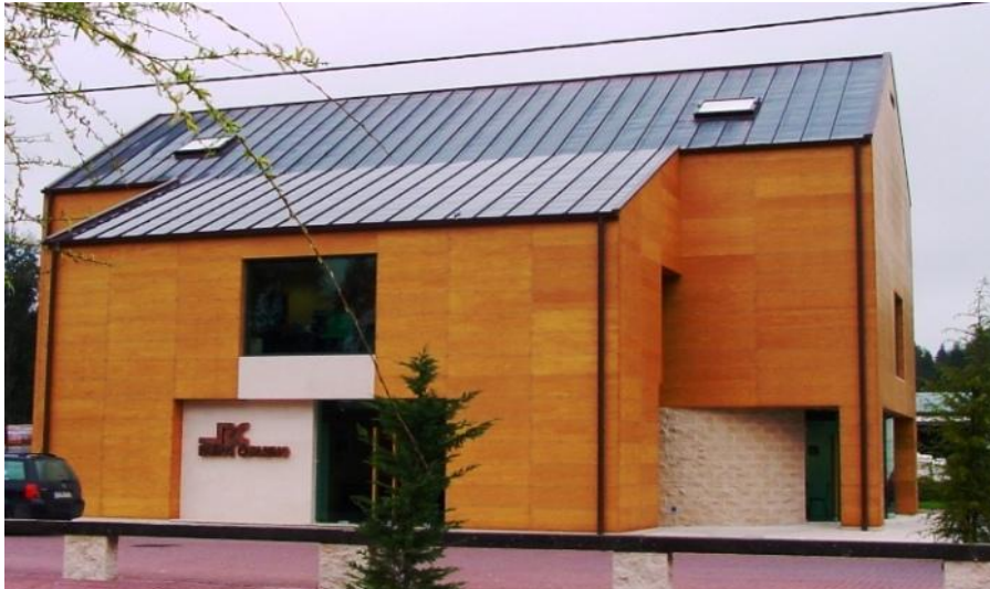
Figura 1 - Actuais instalações Ramos Catarino (Fonte: http://www.grupo-catarino.pt/ ) (20/12/2011 )
