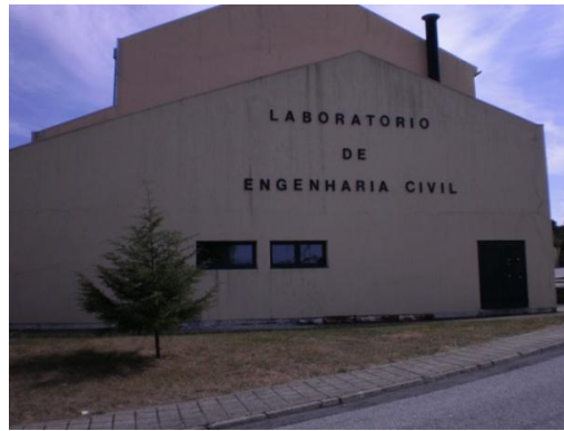
Figura nº 4 - Exterior do Laboratório de Engenharia Civil do IPG
