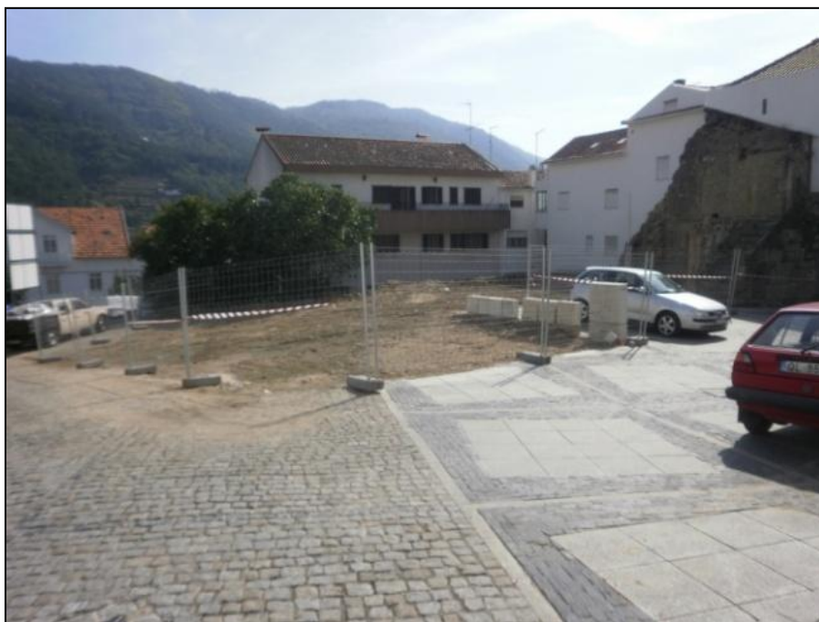
Figura 7- espaço depois da demolição.
