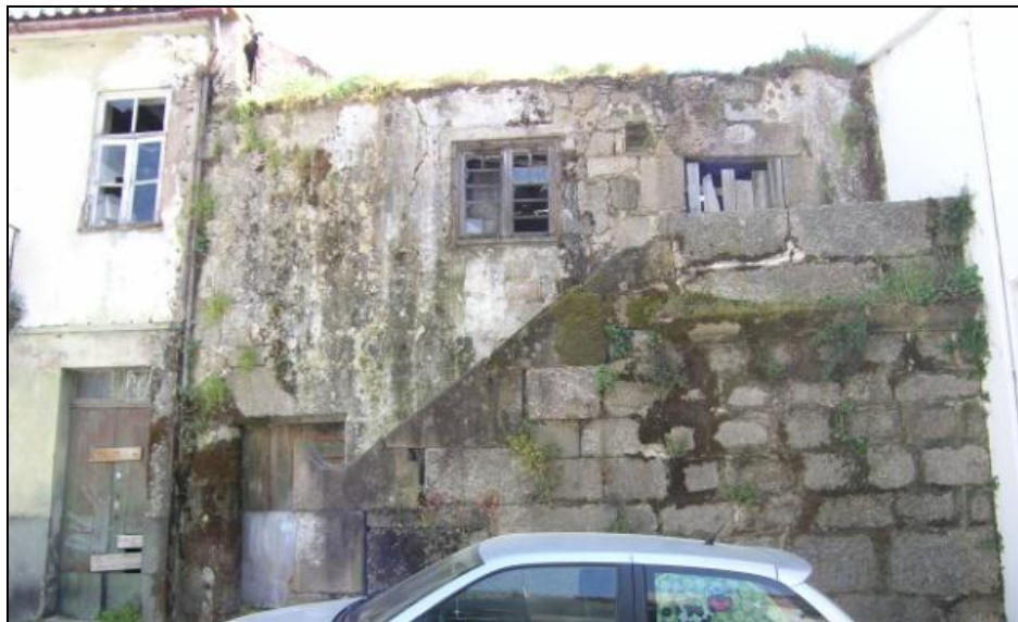
Figura 6- espaço antes da demolição. 4
