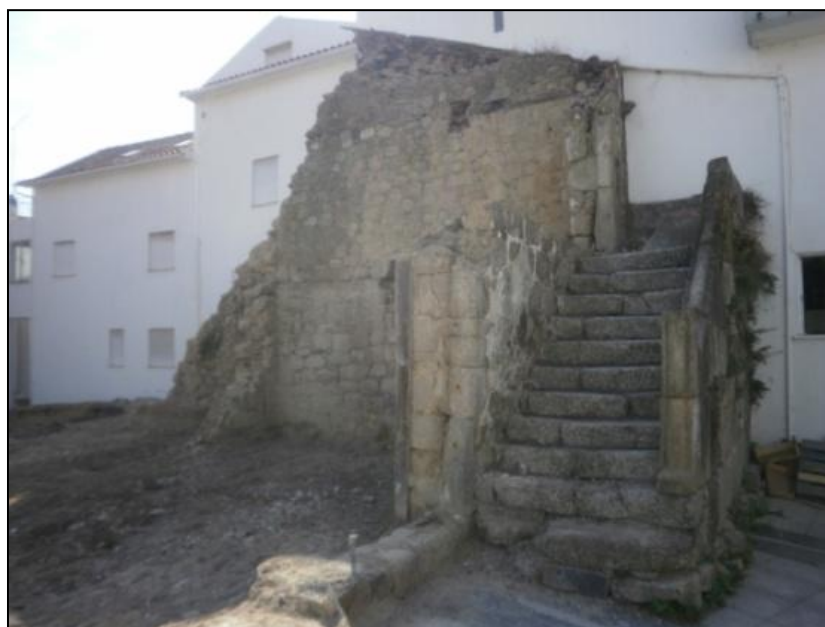
Figura 8- escada e parede meã.
