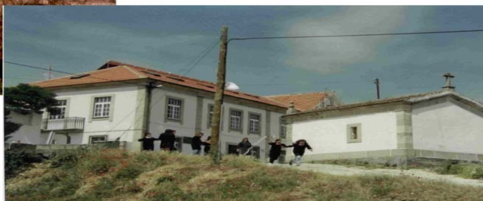
Figura 3 - Entrada e fachada principal
