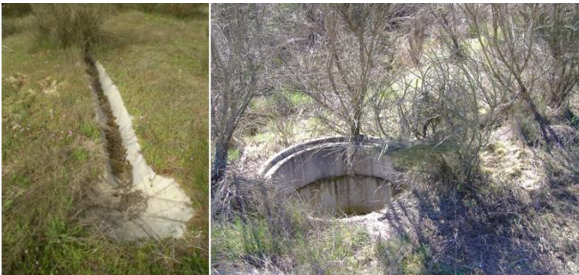
Fotografia 2 e 3 - Sistema de captação e drenagem das águas pluviais (obstruído com vegetação)
