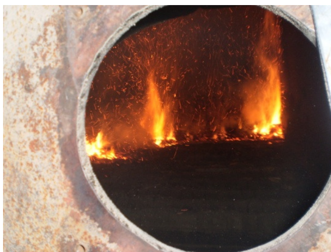
Imagem 49 – Combustão de biomassa no interior da caldeira
