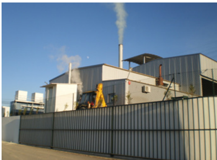
Imagem 46 – Central de termoelectrica de biomassa em Belmonte
