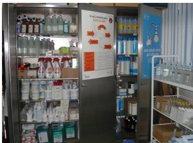
Figura 7 - Armário "corta-fogo" Fonte: SFH do CHSF
