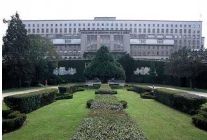
Figura 1 - Hospital São João. Fonte - http://www.chsj.pt
