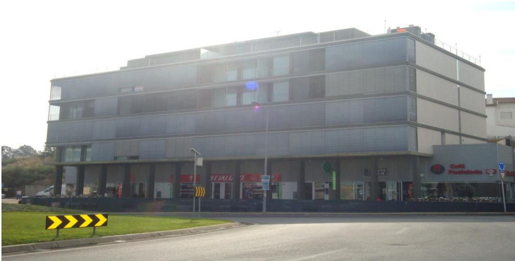
Figura 5 - Edifício da Rotunda realizado pela Gessireal
