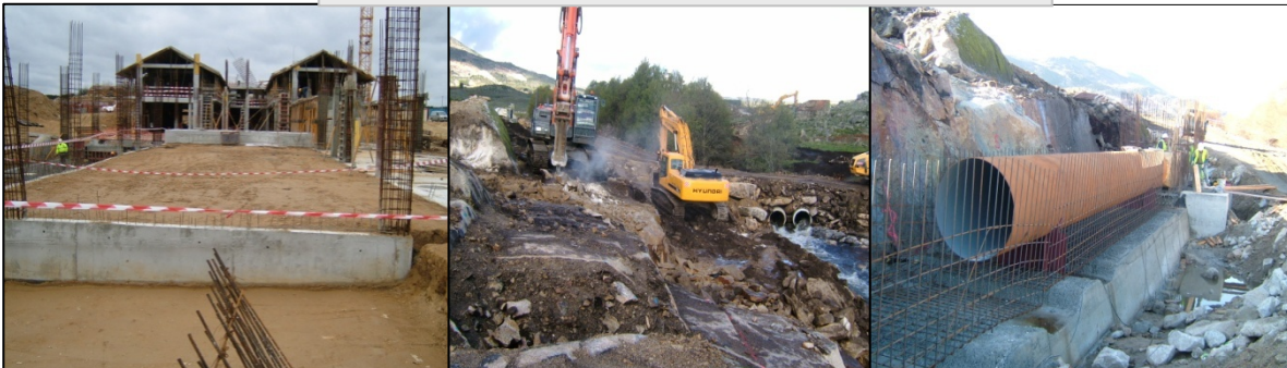
Figura nº 4- Lar de idosos de Meda Figura nº 5- Barragem do Pinhão 1 Figura nº 6- Barragem do Pinhão 2
