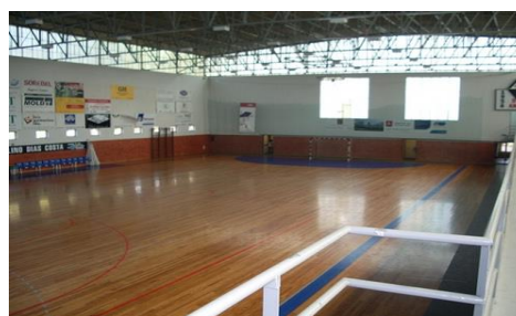
Figura 6 - Pavilhão Desportivo Comendador Adelino Dias Costa - Avanca.
