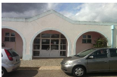
Figura 4: Edifício das Piscinas
