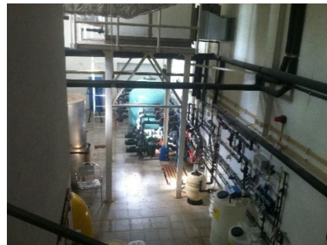
Figura 15: Espaço de manutenção
