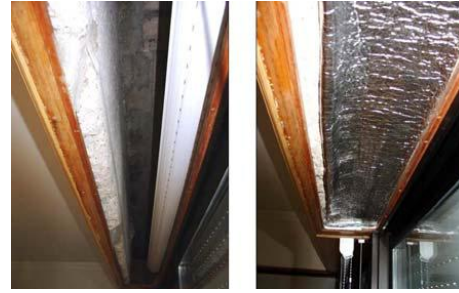
Figura 2.11- Isolamento nas caixas de estore. Fonte: (Gomes, 2010)
