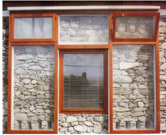
Figura 2.26- Parede Trombe. Fonte: (Gonçalves & Graça,2004)
