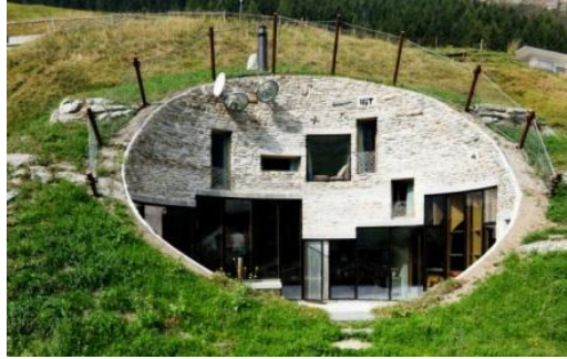
Figura 2.56- Casas enterradas nos alpes, Suíça. Fonte: (Meirelles, 2010).
