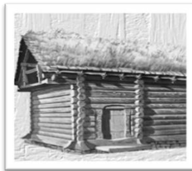
Figura 3.1- Casa de madeira antiga. Fonte: www.casema.pt
