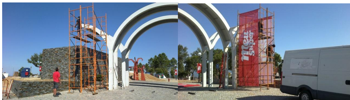
Figura 42 - Construção das colunas.
