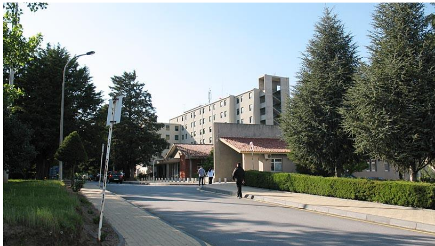
Figura 3- Unidade Hospitalar de Vila Real
