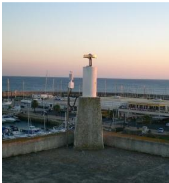
Figura 19 – Primeira estação permanente de GNSS em Cascais perto do marégrafo analógico.
