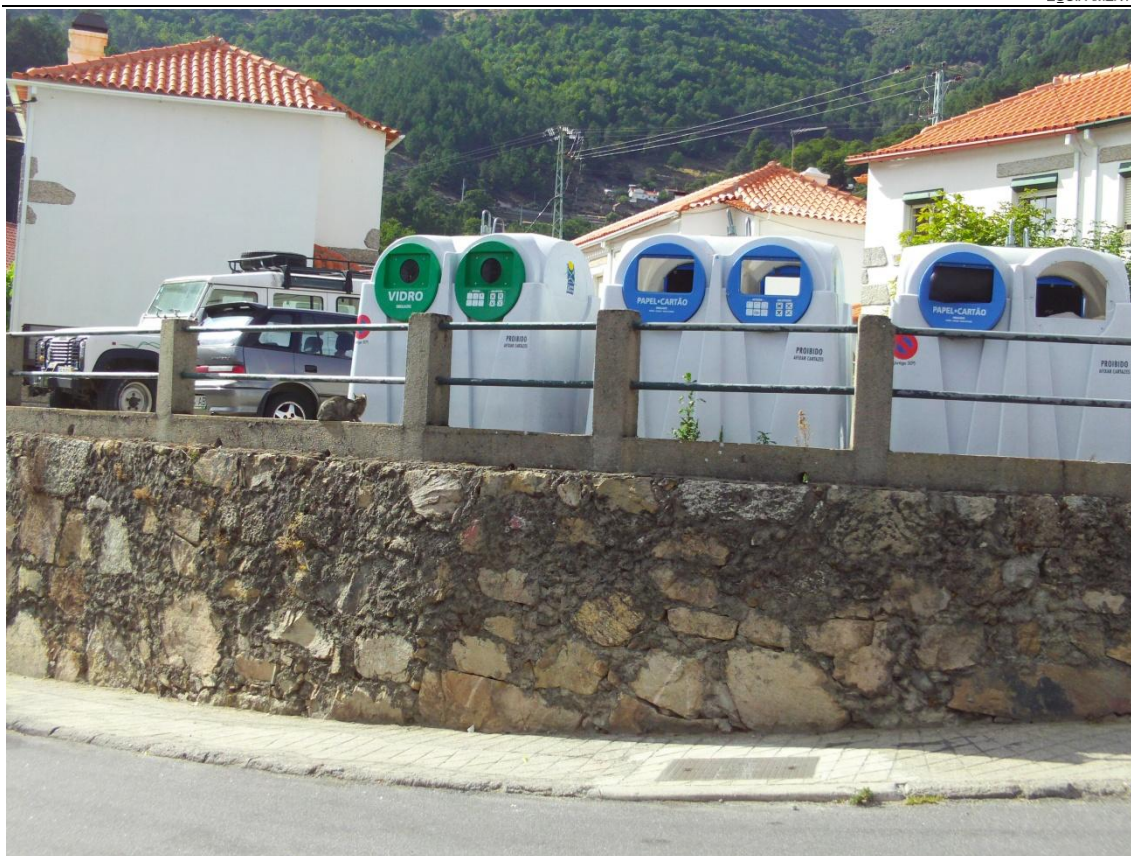
Figura 5 - Destaque para o desnível para a rua a Sul.
