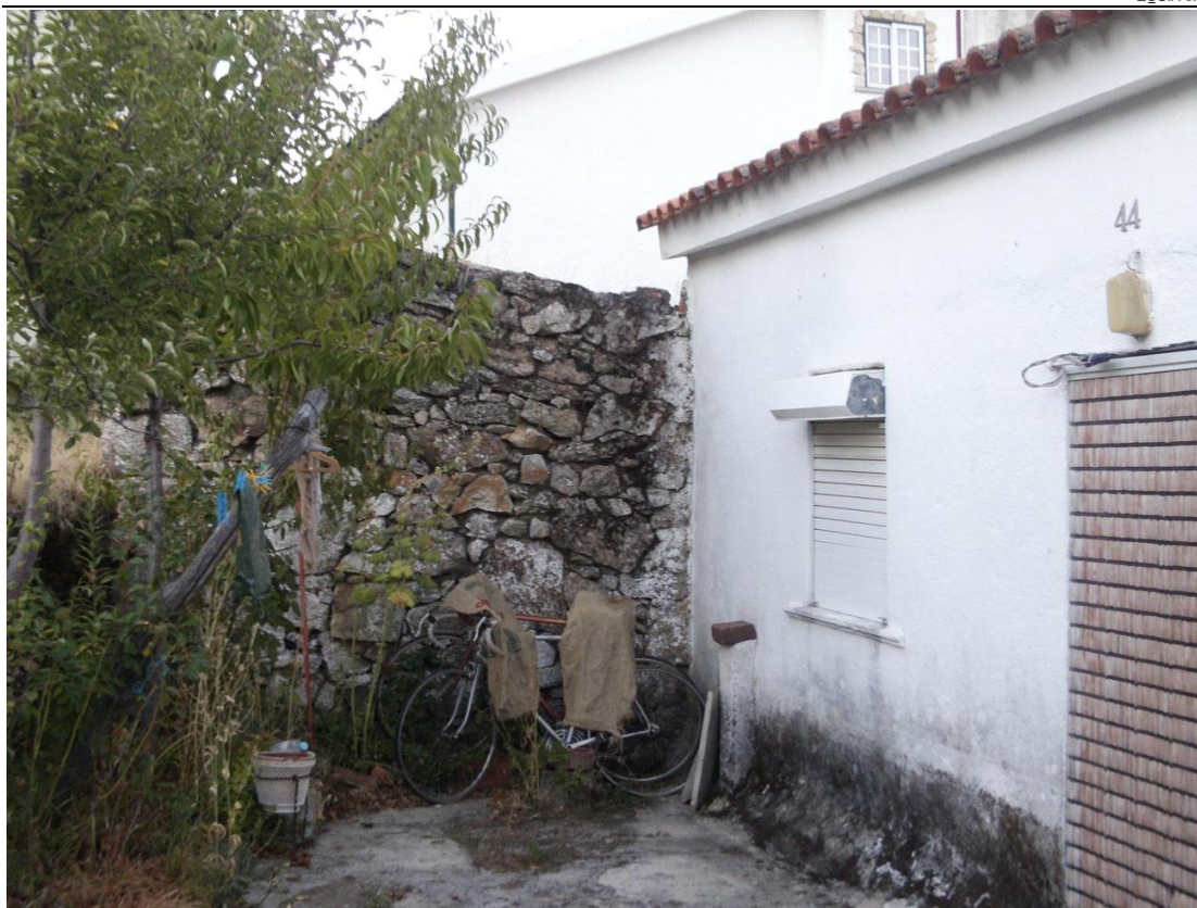
Figura 52 – Pátio de entrada que fará parte, no futuro, da cozinha, aumentando desta forma a área da mesma.
