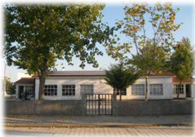
Figura 23 - Escola Básica do Bairro do Pinheiro Fonte: Própria
