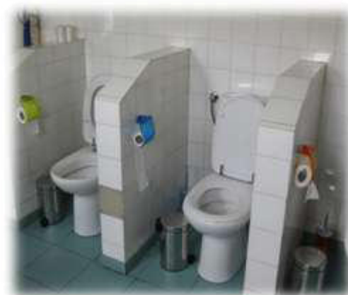
Figura 15 - Local sanitário Fonte: Própria
