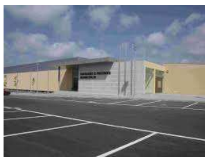
Figura 4 - Pavilhão e Piscinas Municipais do Sabugal
