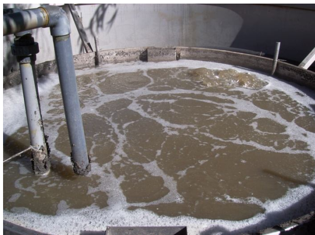
Figura 13 - Tanque de arejamento.
