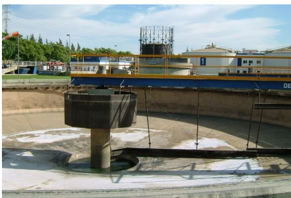
Figura 7 - Exemplo de decantador primário [4]
