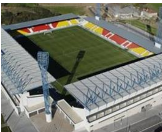
Figura 1 - Estádio Cidade de Barcelos 2
