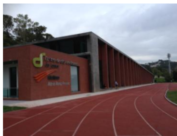
Figura 4: Nave coberta - Jamor
