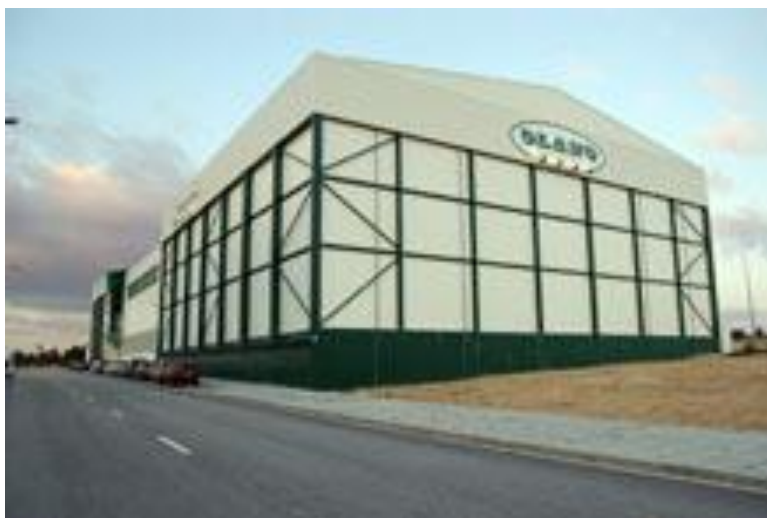
Figura 9-Instalações da Olano Logística Do Frio
