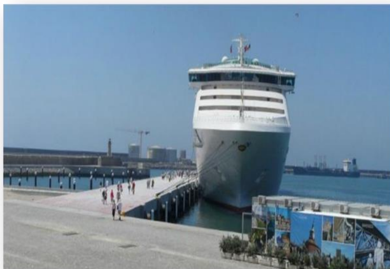
Figura 6 - Cais do Porto de Leixões
