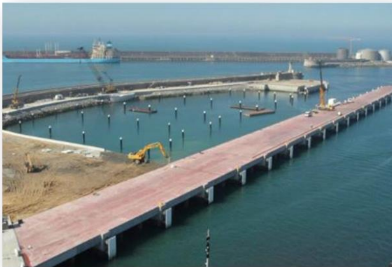
Figura 7 - Cais do Porto de Leixões
