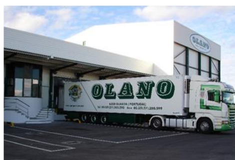
Figura 20. Cais e entreposto da OLF.
