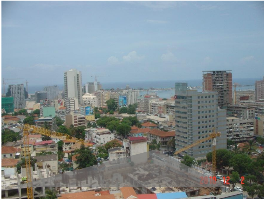
Fig.6 – Enquadramento real do futuro edifício
