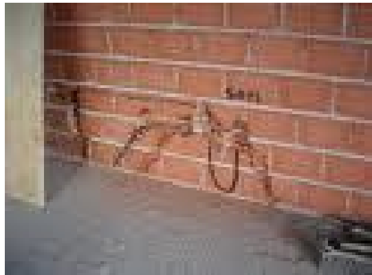
Figura 2: Abertura de roços
