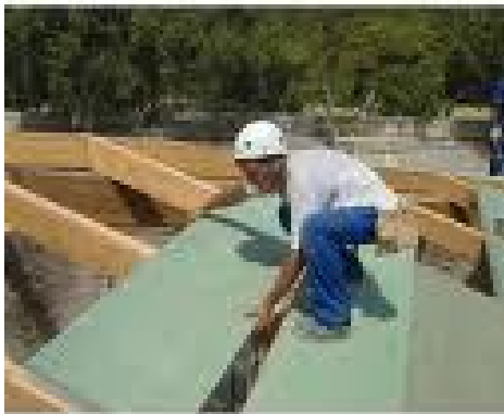
Figura 9: Colocação do painel sanduíche
