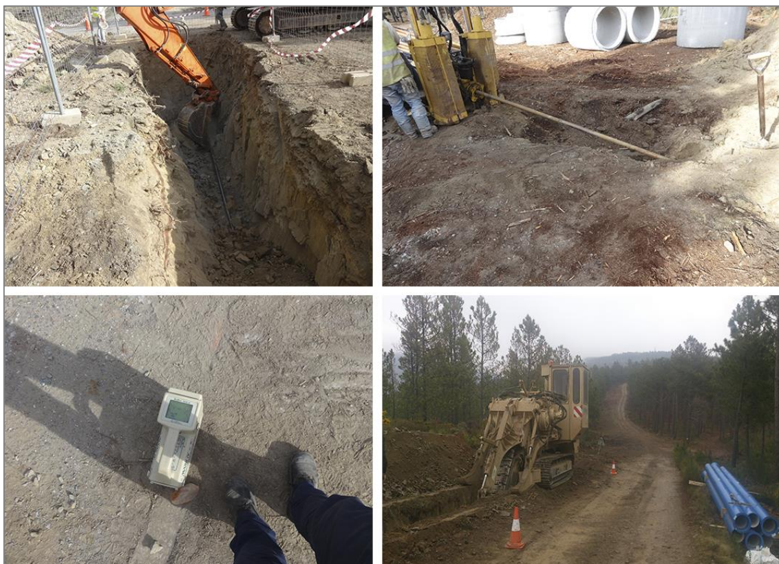
Figura 40 - Perfuração horizontal e escavadora
