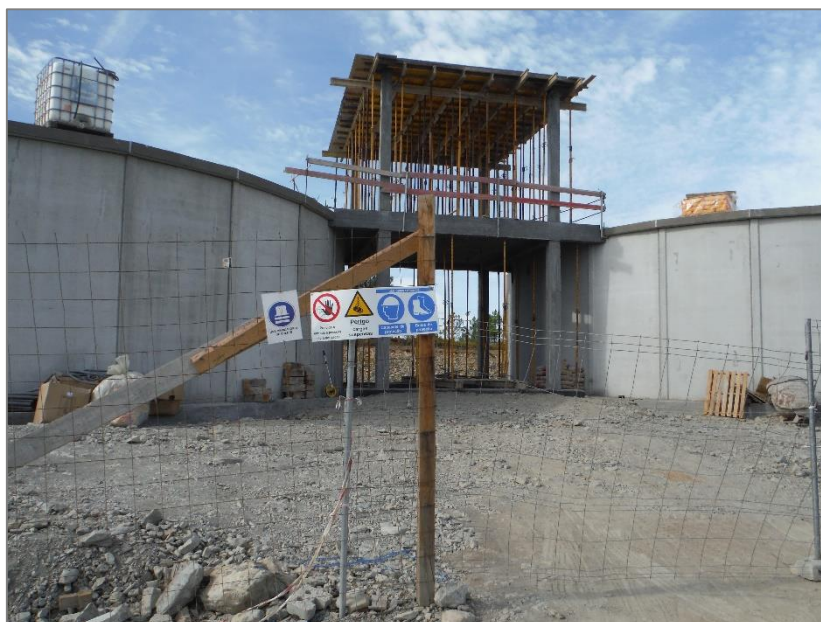
Figura 3 - Reservatório, em construção
