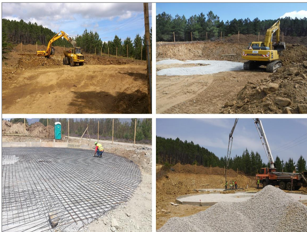
Figura 34 - Escavação e execução de fundações – Reservatórios
