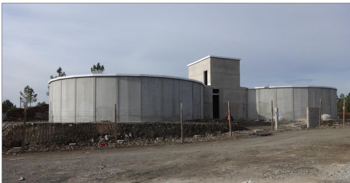
Figura 18 - Reservatório em construção (2000 m 3 )
