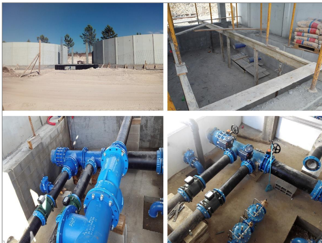
Figura 36 - Camara de Manobras – Reservatórios
