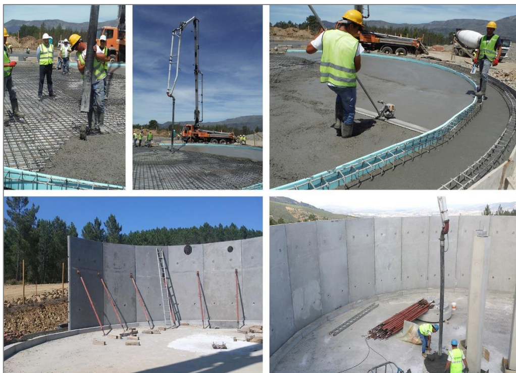
Figura 35 - Execução de fundações e Pré-fabricados – Reservatórios
