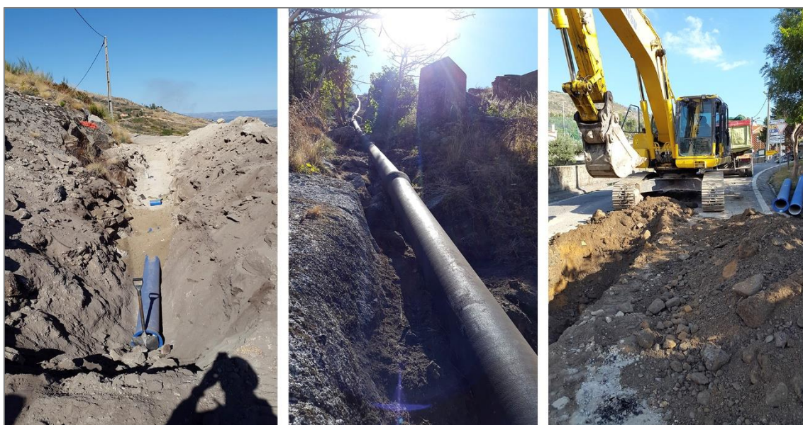
Figura 37 - Trabalho de execução de condutas adutoras
