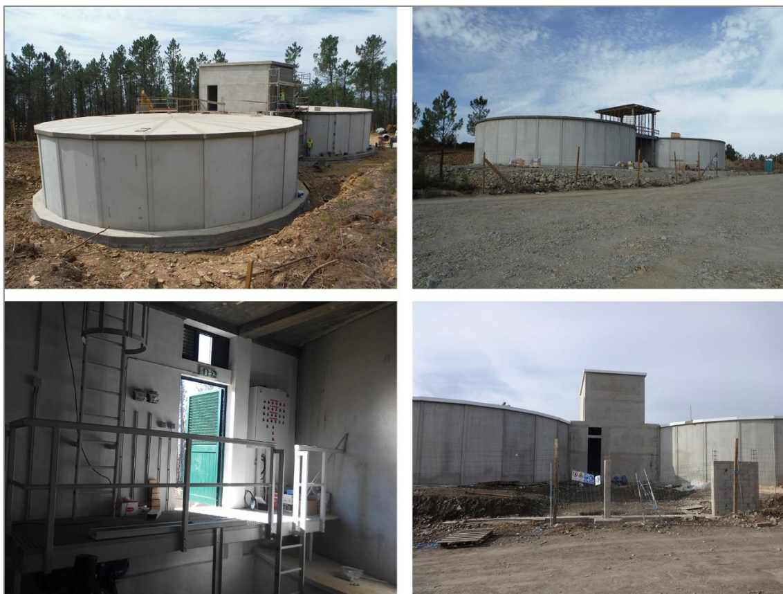
Figura 39 - O Reservatório em execução
