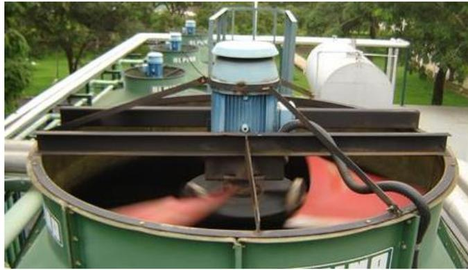
**Figura 21** - Ventilador da Torre de arrefecimento
