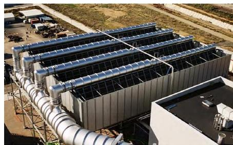
**Figura 15** - Torres de arrefecimento híbridas [6]
