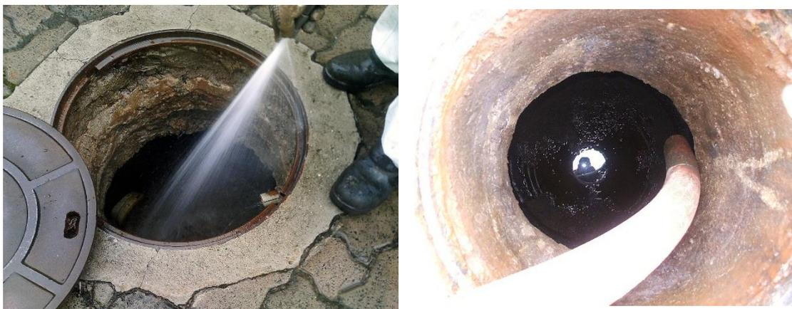
**Figura 42 - Limpeza e remoção de lamas da fossa séptica**
