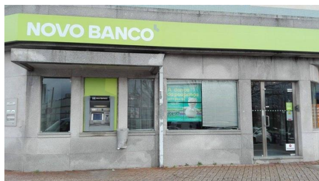
Figura 5: Balcão da Guarda-Gare
