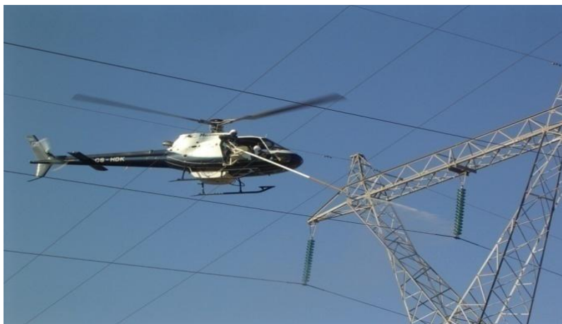
Figura 4: Trabalhos em Alta – Tensão – EC 120
