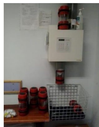
Figura 8. Sistema de transporte pneumático.
