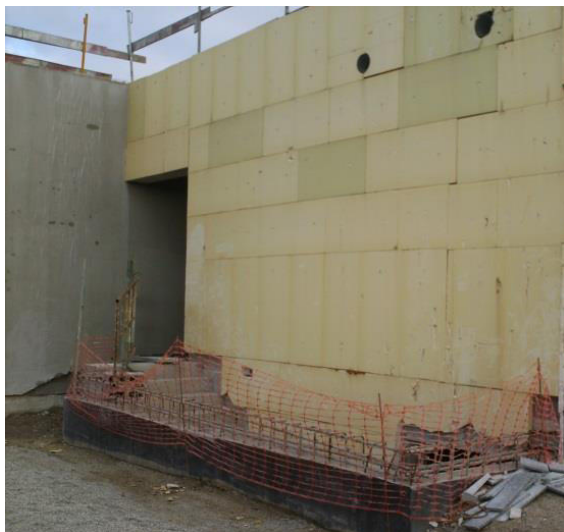
Figura 19: Isolamento térmico à vista no alçado sul.
