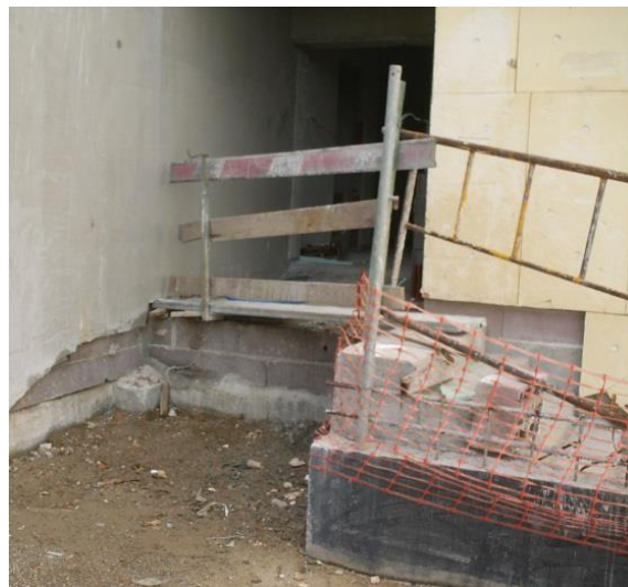
Figura 20: Acesso exterior ao corredor técnico.
