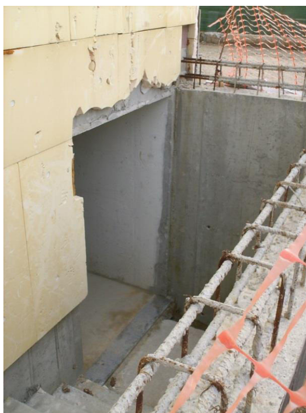
Figura 21: Acesso à cave.
