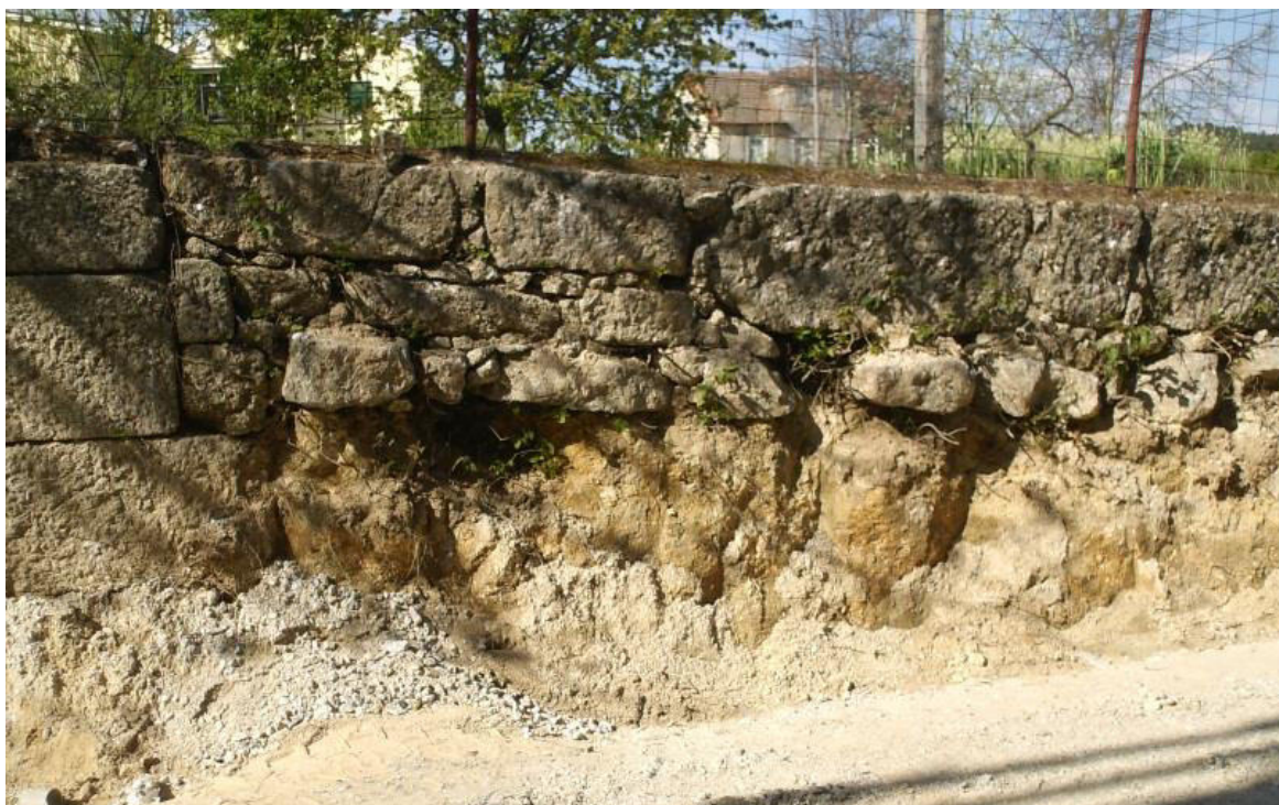
Figura 39: Muro lateral antes da execução do canteiro.
