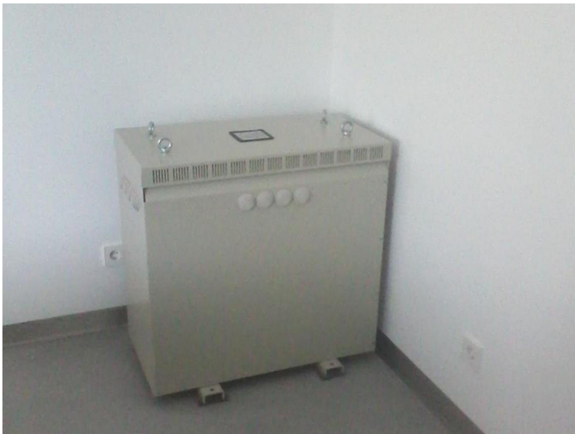
Figura 47: Transformador de isolamento.
