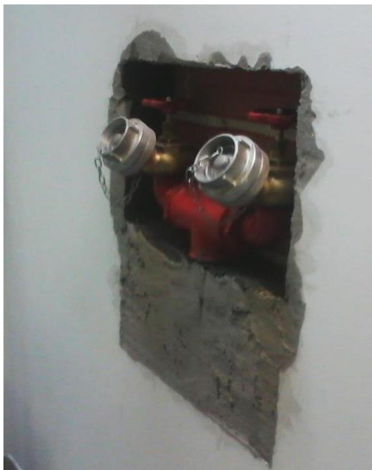
Figura 50: Válvulas globo aplicadas em substituição da siamesa e caixa anteriormente aplicadas.
