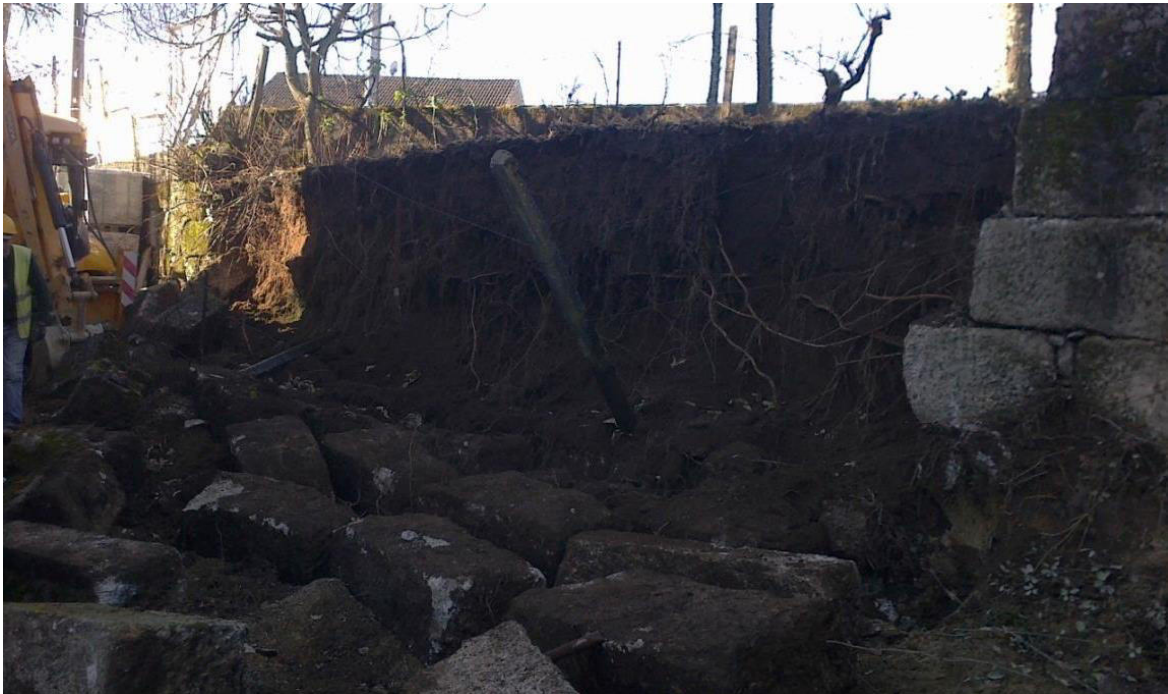
Figura 37: Pedras constituintes do muro e terreno adjacente.
