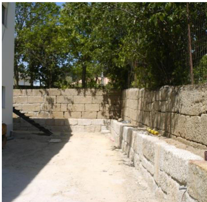
Figura 42: Vista do muro reconstruído e canteiro a partir da rampa de acesso principal.
