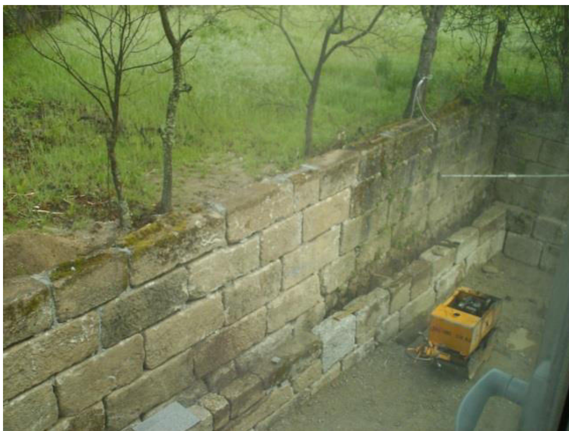
Figura 40: Vista do muro reconstruído e canteiro a partir do piso 1.
