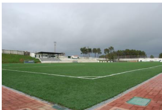
Figura 4 – Estádio municipal do Fundão (Fonte: http://imprensa.cm-fundao.pt/desporto/estadio.jpg )
