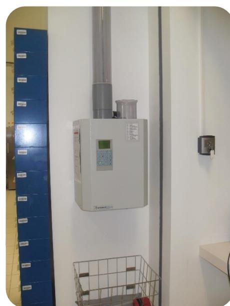
Figura 15- Sistema de vácuo transportador de medicação.
