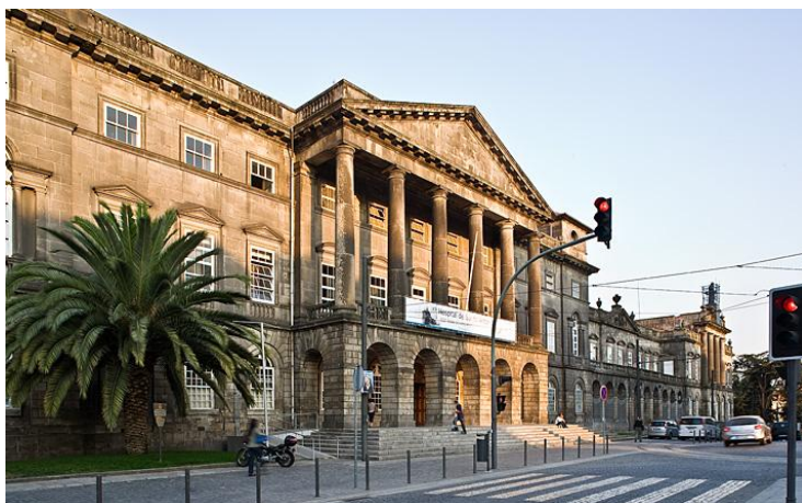
Figura 1 Edifício Dr. Luís de Carvalho
