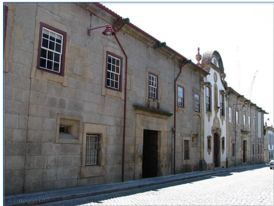
Figura nº 13 - Edifício do Paço da Cultura e do Museu da Guarda.
