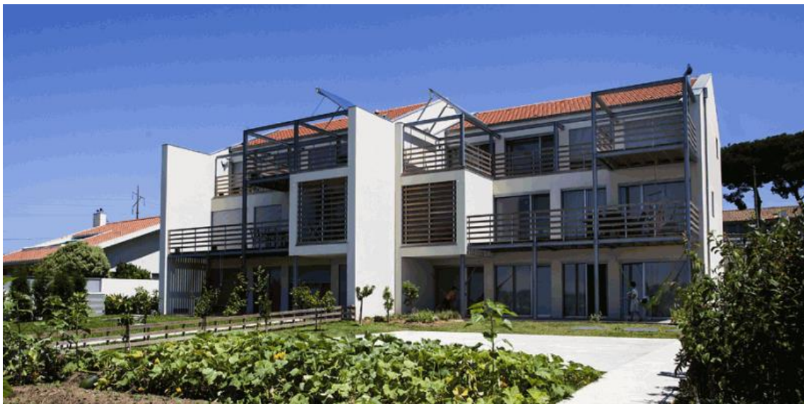
Figura 32- Vista da parte exterior das Moradias A e B em Ílhavo [37]
