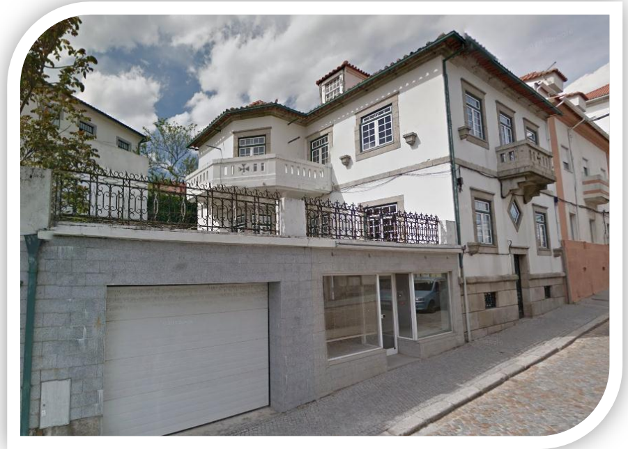
Figura 32 - Edifício em estudo na cidade da Guarda
