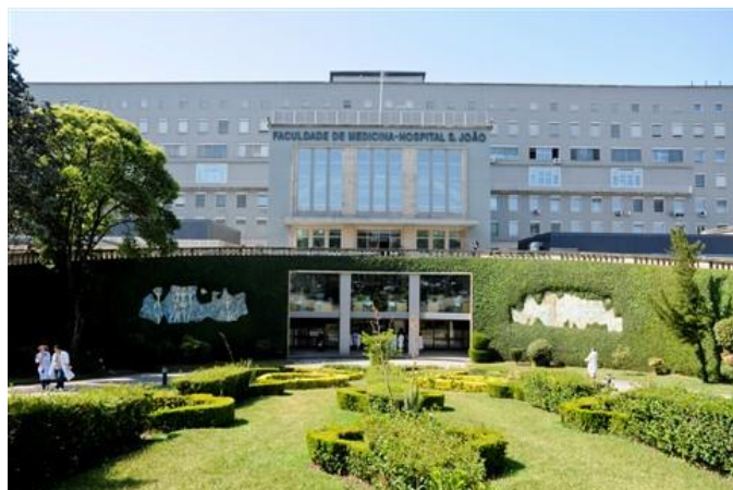
Figura 1- Edifício frontal do CHSJ, EPE
