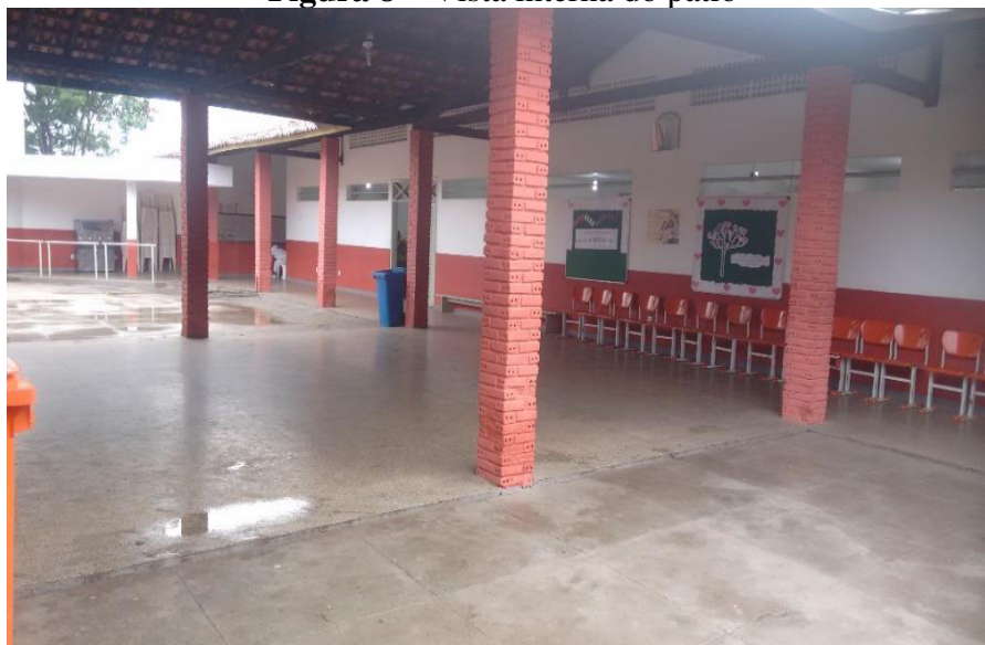
Figura 8 – Vista interna do pátio
