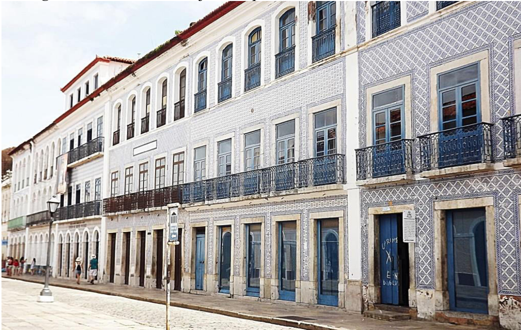
Figura 2 – Fachada do conjunto arquitetônico de casas do centro histórico
