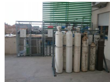
Ilustração 7 -Armazém de Gases medicinais e produtos inflamáveis
