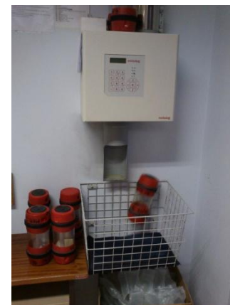
Ilustração 11 - Sistema pneumático
