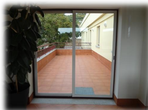
Figura 8: Varanda da Residência Fonte: Própria
