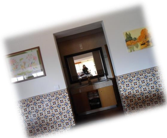
Figura 7: Casas de banho do piso 1 Fonte: Própria
