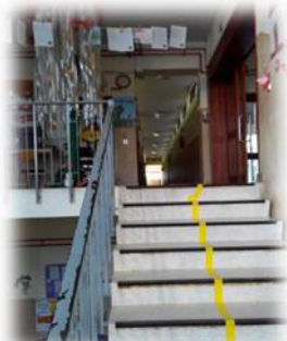
Figura 15. Escadaria de acesso ao 2º piso Fonte. Própria
