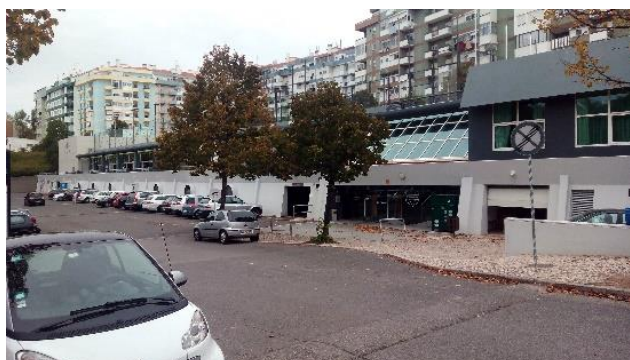
Figura 1 - Entrada do Ginásio (fonte própria)
