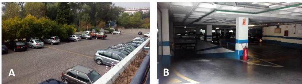
Figura 24 - Parques de estacionamento exterior (A) e interior (B). (fonte própria)
