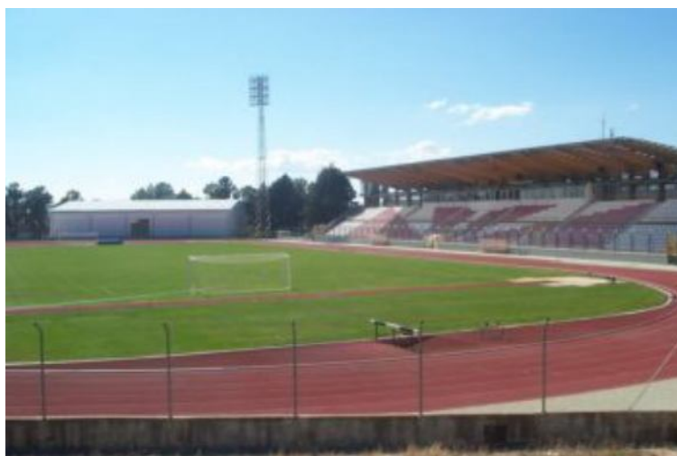
Figura 10 - Estádio Municipal da Guarda
