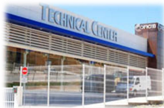
Figura 2 - Instalações exteriores do Technical Center da COFICAB Portugal
